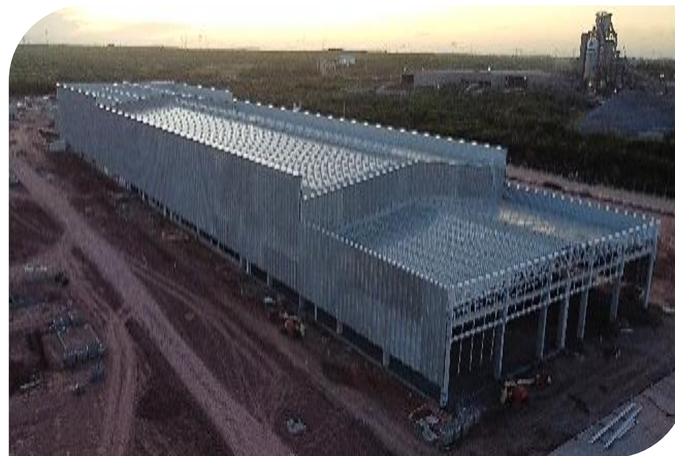
Nova unidade de fibrocimento – Caucaia-CE
