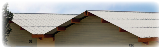
Aplicação de telhas de fibrocimento Vogatex
